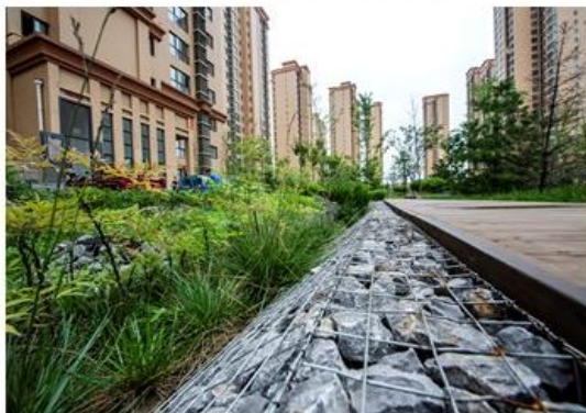
天福和园滤水石笼、下凹式绿地
