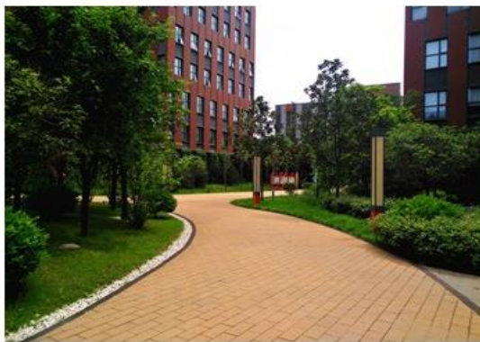
西部云谷透水铺装、下凹式绿地
